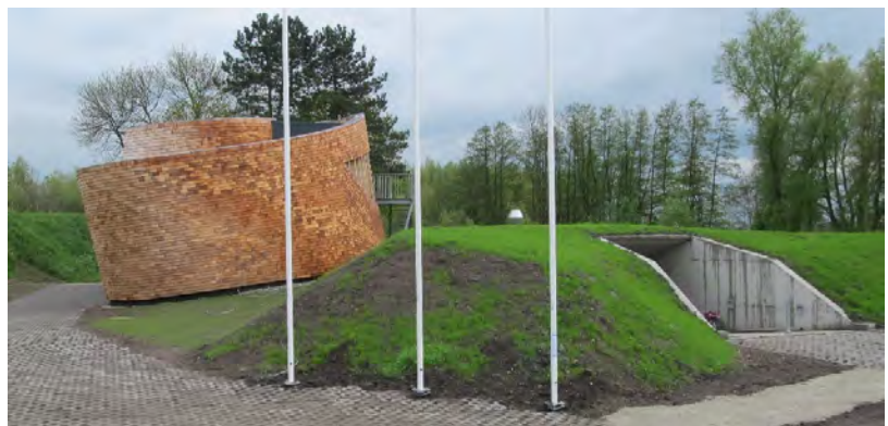
Aardwerk met ingebouwde voorzieningen
